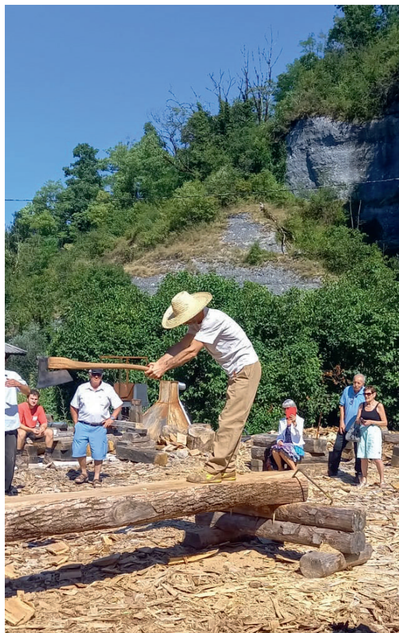
Équarrissage d'une poutre
